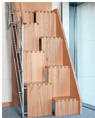
Anspruchsvolle Raumpartrepp mit schönen konstruktiven Details
